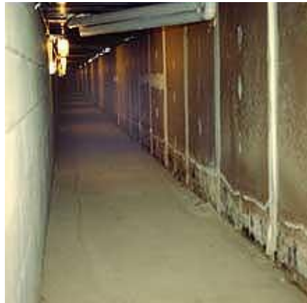
Crescita dello Stachybotrys chartarum alla base di paratie di carton gesso, in una scuola, negli U.S.A. (Foto di B.D. Nelson, fornita cortesemente dalla American Phytopathological Society)
